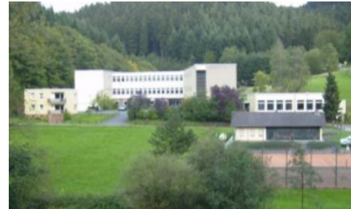
Abb. Leerstehende Schule in Daun
