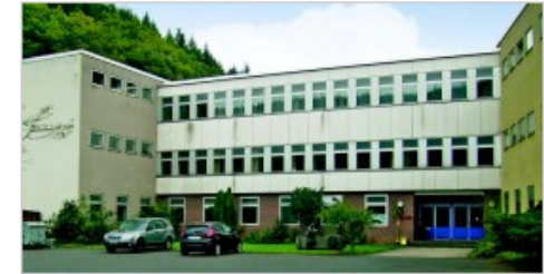
Neue Nutzer gesucht: Aus der ehemaligen Grund- und Hauptschule in Niederstadtfeld könnte ein Jugendhotel werden.
